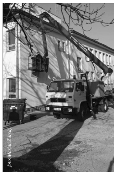
V úterý 17. března pracovníci Domu kultury za vydatné pomoci Technických služeb instalovali na fasádu navigační ceduli k malému sálu a k Čajovně Magnolia
